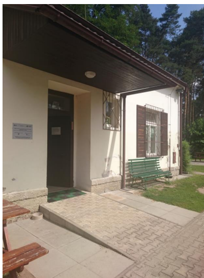
Vstup do budovy s BB WC
