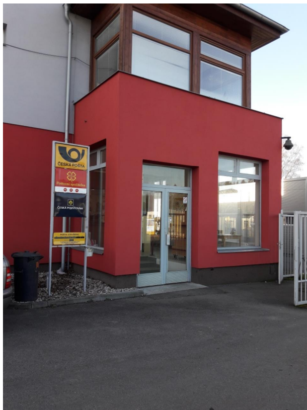
Vstup do budovy
