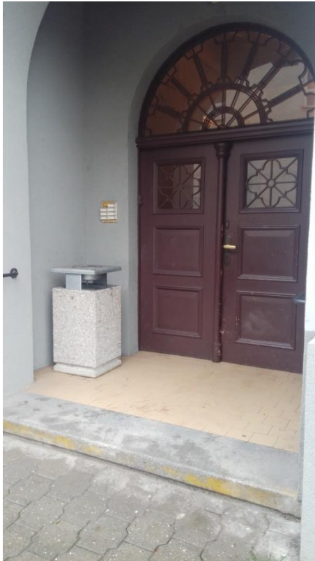
Vstup do budovy
